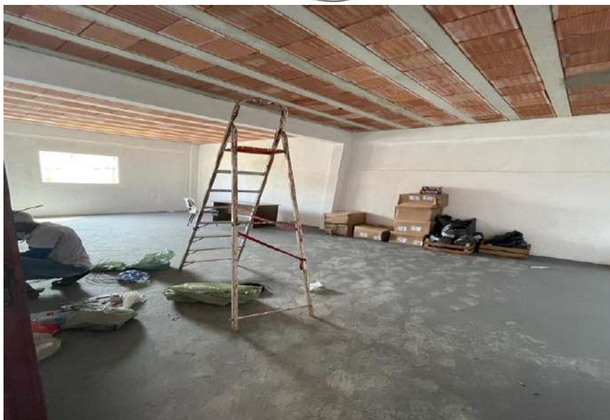
Manutenção e instalação elétrica Figura – 9
